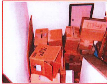
階段や通路に避難上の支障あり
